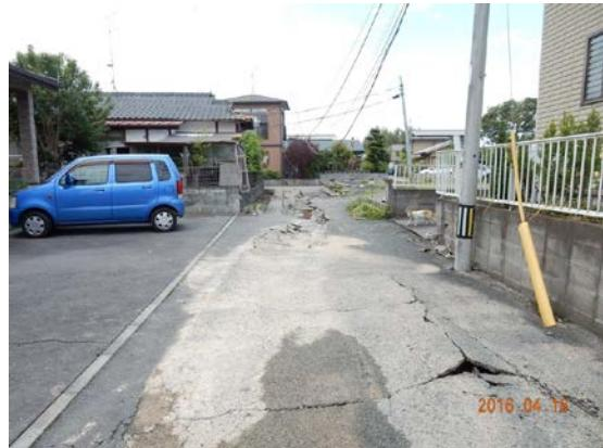
写真2.20 埋戻し土の液状化被害 (H1地点)
