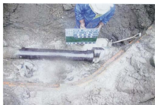
写真2.23 水道管の継手の抜け（千葉県による）<sup>69)</sup>
