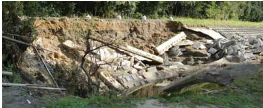
堤体表面を保護しているコンクリートがあっても、流速・流量によっては侵食される恐れがある。
