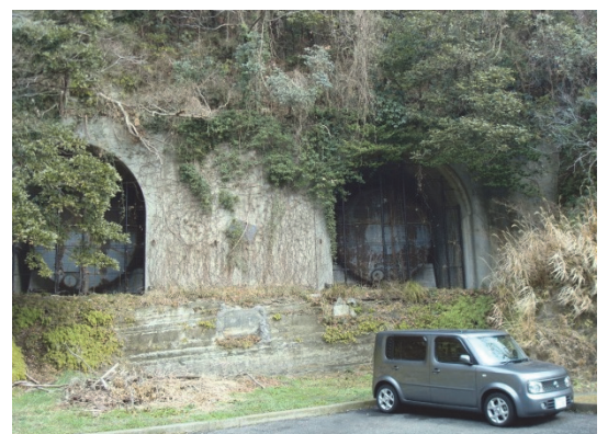
右写真：丘陵南側斜面 手前は切土面露頭，背後に横坑(内部にタンク油槽)
