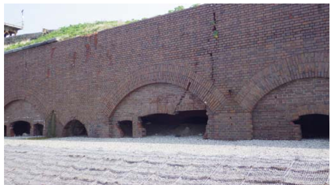
写真-2 掩体壕の跡と対候性に優れた高温焼成 「焼き過ぎ煉瓦」を積んだ壁
