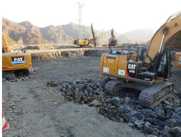
写真-2 岩のてっぺんで進行する撤去工事
