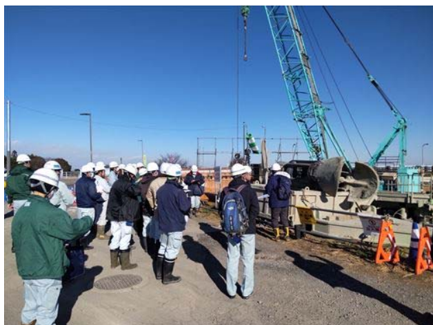
写真-1 A1 橋台下部工掘削工事の見学の様子
