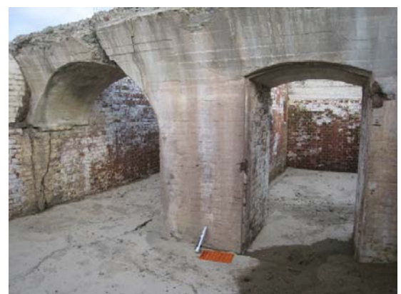
写真3 西端掩蔽壕（壁：普通煉瓦，天井：コンクリート）
