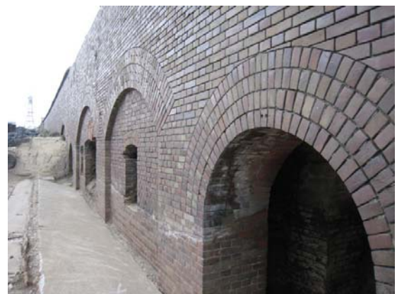
写真2 北側掩蔽壕（表面：焼過煉瓦）
