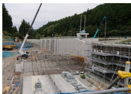
写真-2 大芦川取水放流工の建設の様子
