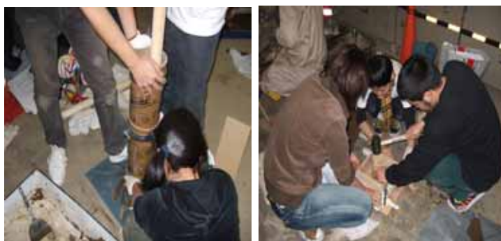
写真-3 参加者手作りの型枠と締りめ用具
