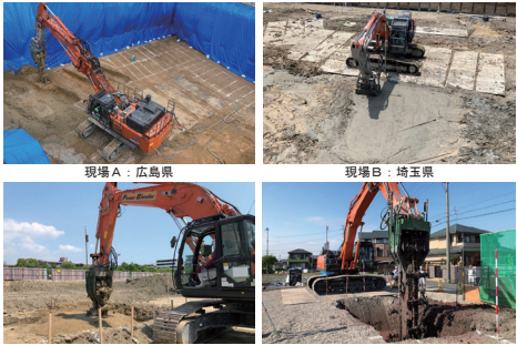
トレンチャ式地盤改良工法の建築基礎への適用状況
