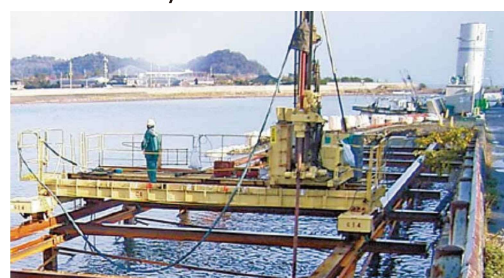
SJMM-Dy工法施工状況(スライドベース施工)
