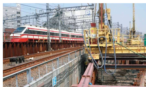
LDis-Dy工法施工状況(営業線近接施工例)
