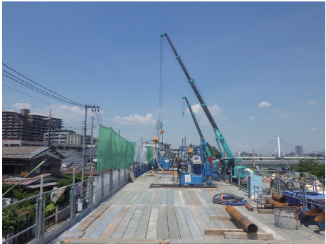
地盤改良による施工状況
