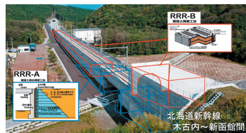
補強土 (RRR) 工法を用いた施工事例
