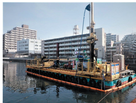
高圧噴射攪拌工法施工状況
