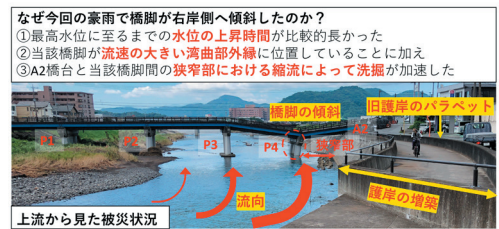
令和3年7月1日から続く大雨で被災した黄瀬川大橋とその上流右岸部の様子
