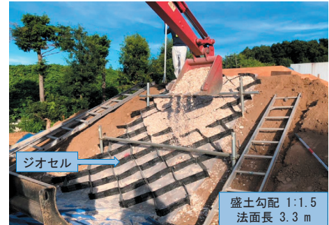
ジオセルを用いた貝殻型CB盛土の破碎貝殻充填作業
