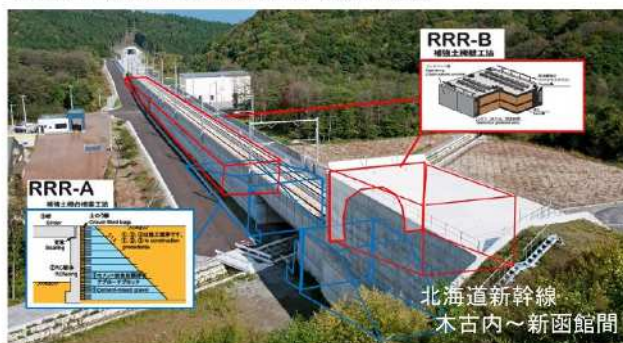
補強土工法（RRR工法）を用いた施工事例
