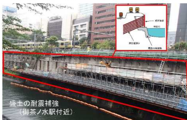
耐震補強の施工事例（防災関連）
