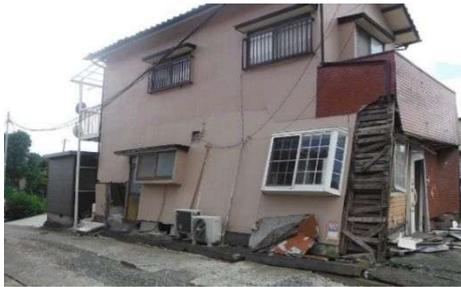
写真 5.1 池を埋めた箇所の被害
