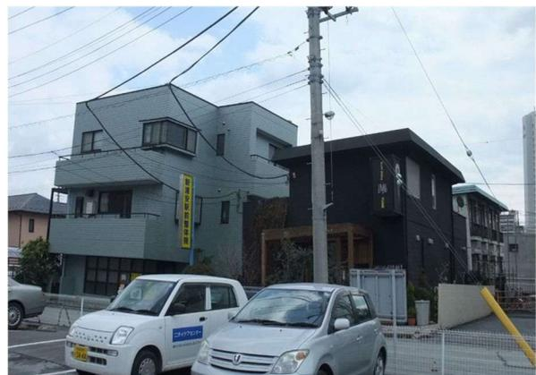
写真 1.1 東日本大震災で液状化によりめり込み沈下と傾斜した建物
