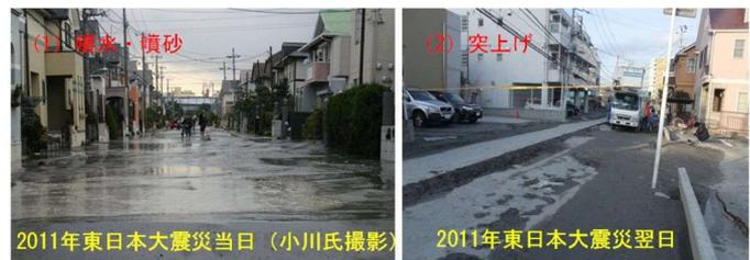
写真 10.1 噴水・噴砂、突上げの事例
