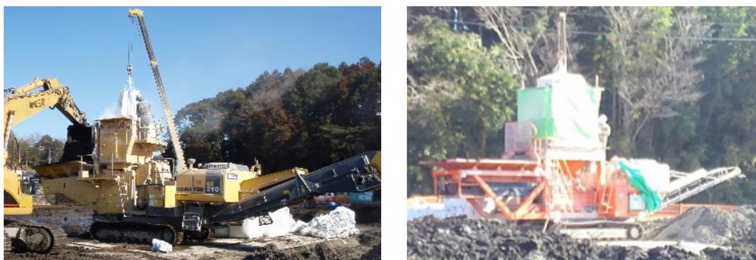
図 7.5 自走式プラント混合の例
