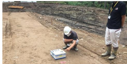
(f) RI 計器による締固め管理
