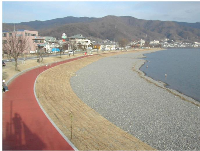
図 8.11 改質土で構築した湖内傾斜護岸(渚護岸)<sup>8)</sup>
