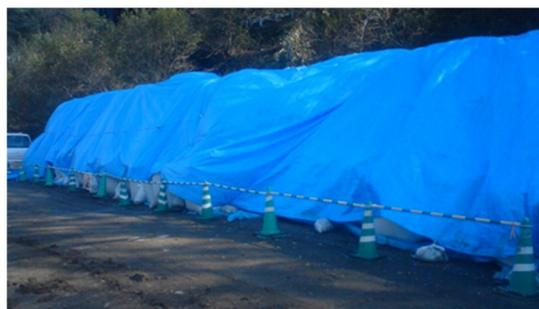
図 7.7 現場における PS 灰系改質材の保管例
