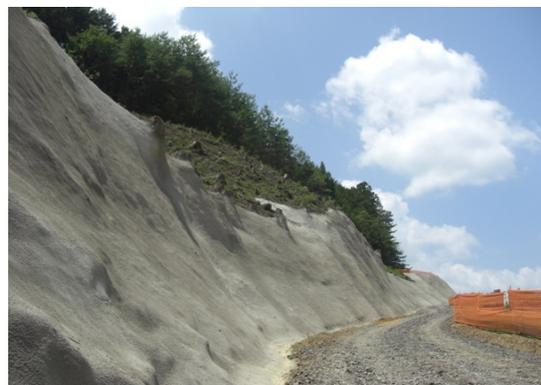
写真 3.1 コンクリート吹付け工
