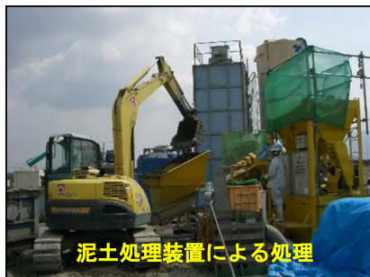
写-2.鋼管ソイルセメント杭の余剰排泥処理
