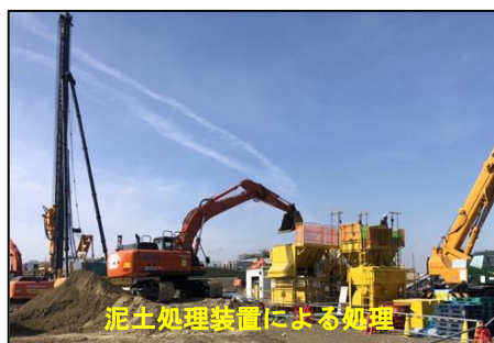
写-3.地盤改良工事の余剰排泥処理
