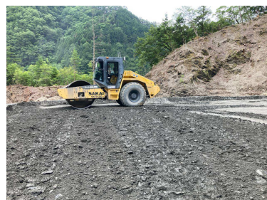
写真 2 11t 級振動ローラーによる転圧状況
