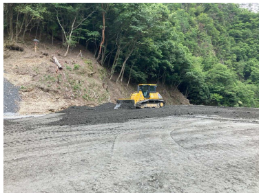
写真 1 砂利洗浄汚泥処理物の敷均しの状況
