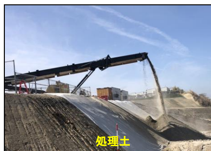
写-3.地盤改良工事の余剰排泥処理
