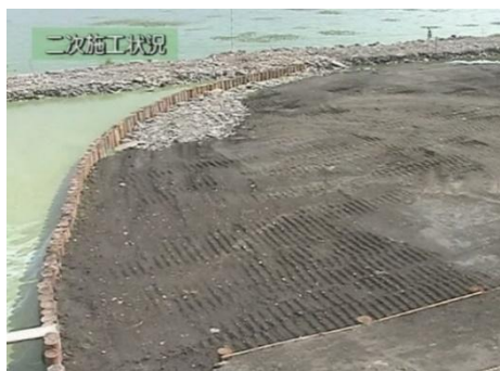
(e) 土留め壁による拘束と表面流出対策
