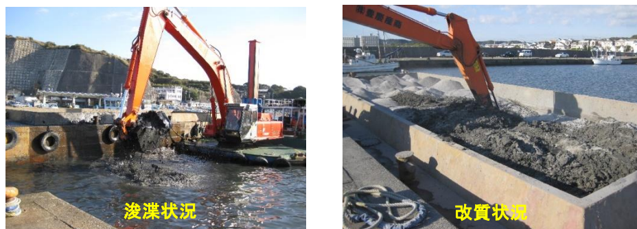
図 4.12 B 漁港での改良工事の施工状況
