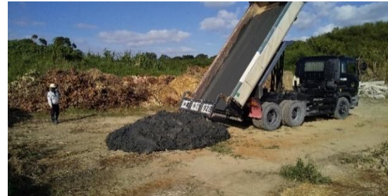
写真 6.4 浚渫泥土の仮置き
