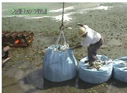
(a) 大型土のうの設置
