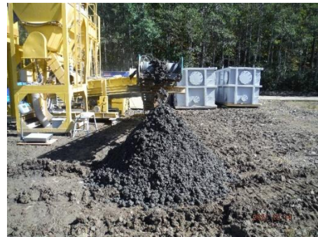
(b) 実機処理土（貯水池底泥土用改質土）
