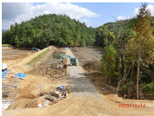
写真－1 ため池底泥土採取状況
