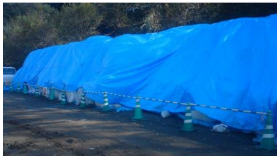
図 3.7 現場における PS 灰系改質材の保管例
