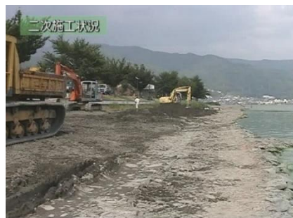
(d) 第 2 期施工状況
