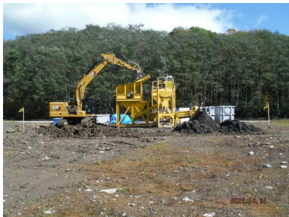
写真－7 貯水池底泥土改質実証試験状況
