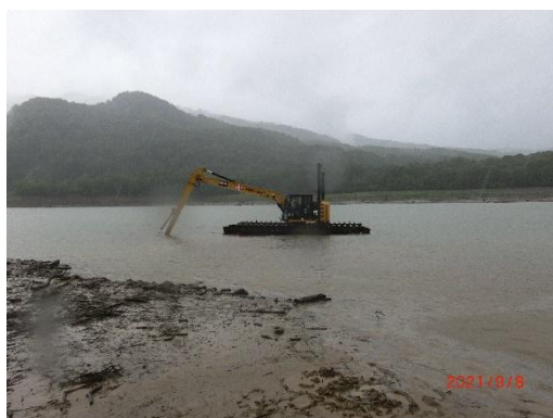
写真－3 貯水池底泥土採取状況
