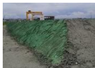
(h) 改質 1 か月後（吹付実施） 2 か月間安定
