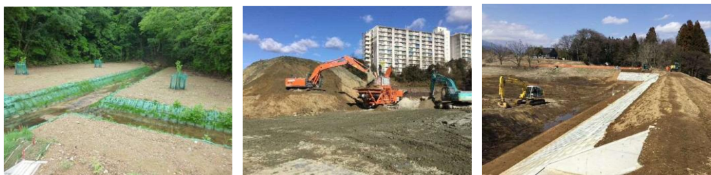
図 2.4 農業用ため池工事での適用例（盛土・堤体工事）
