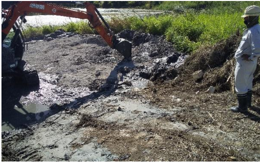
写真 6.1 バイオマス灰系改質材の添加
