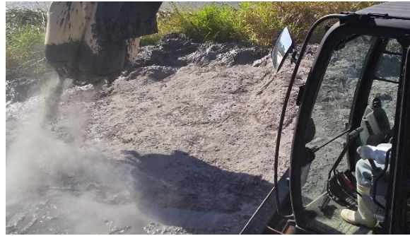
写真 6.2 浚渫泥土の改質攪拌
