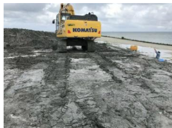
(e) 重機乗り入れ
