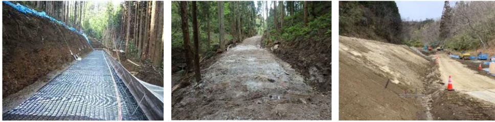
図 2.9 砂防・林道・地すべり対策工事への適用例
