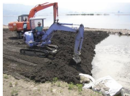
(b) 改質土投入，片押し排水ブル転施工
