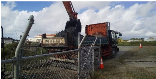
写真 6.3 改質土の運搬
