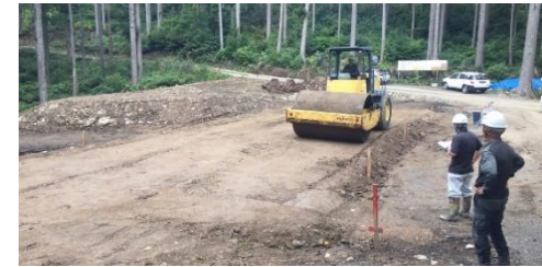
(d) 振動ローラによる転圧
