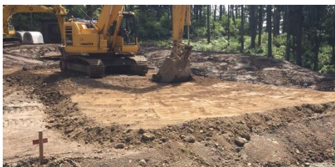
(c) 撒き出し・敷均し
