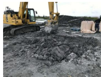
(c) バックホウ攪拌混合
