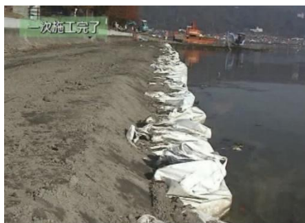
(c) 被覆土後，第 1 期施工完了
