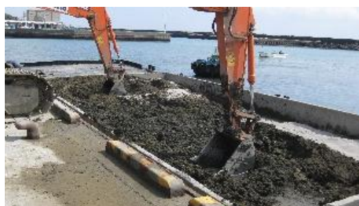
(b) 貯泥ピット内での混合
