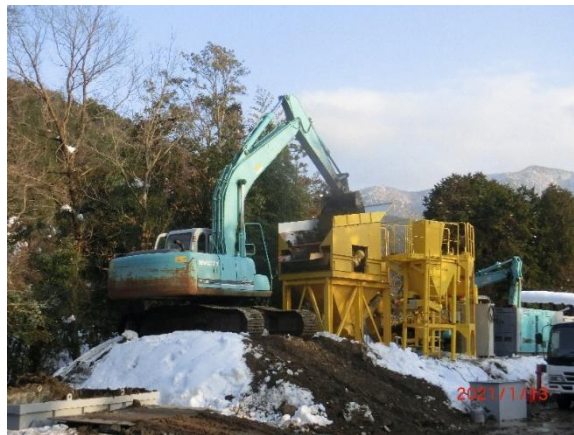
写真－５ ため池底泥土改質実証試験状況
