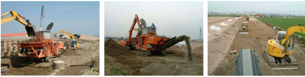
図 2.7 道路工事への適用例
