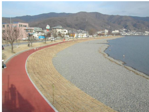
図 5.10 改質土で構築した湖内傾斜護岸(渚護岸) 7)
