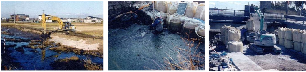
図 2.5 水路工事・排水路工事への適用（土砂搬出・再利用）
