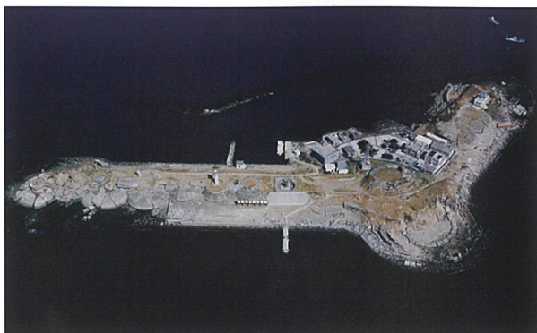
写真8：護岸整備工事着工前 平成16年(2004)3月撮影
