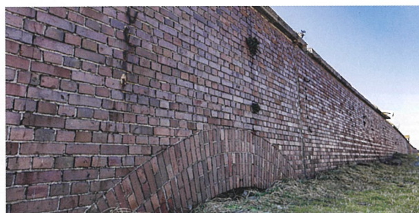
写真4：右翼北側の掩蔽壕 令和2年(2020)3月18日撮影
