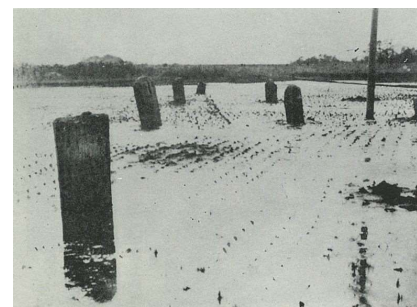
関東大震災100年：痕跡を訪ねる 神奈川・茅ヶ崎 旧相模川橋脚 液状化で水田に出現 (東京 | 毎日新聞)
