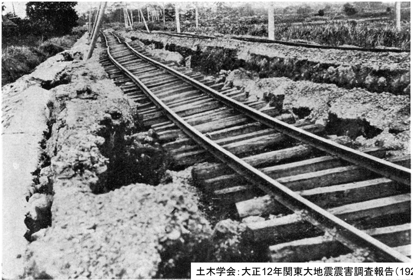
國有鐵道 東海道本線茅ヶ崎馬入川間築堤の大罅裂
