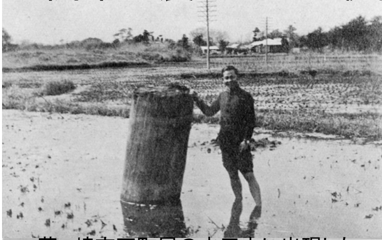
茅ヶ崎市下町屋の水田中に出現した 鎌倉時代の橋の橋脚
