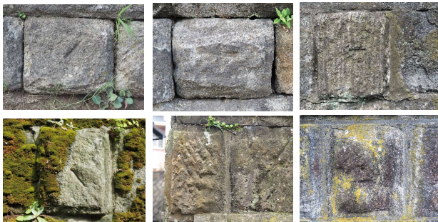
図 18 東京湾岸の刻印石 左上より横浜地方气象台擁壁：ㄐ, ト, 横浜市山手町民家の擁壁：I, 横須賀市汐入小学校擁壁：ㄐ, 富津市金谷町民家の堀：I, 別の民家の堀：II
