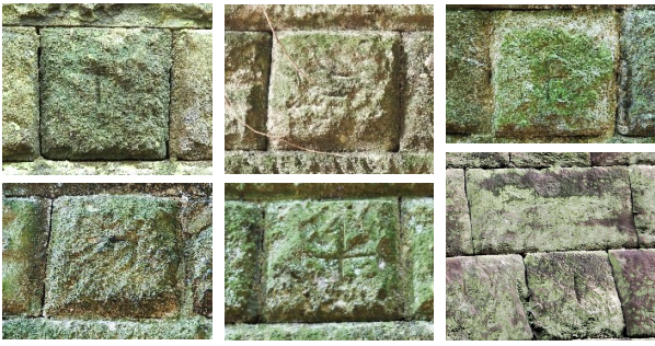
図 12 猿島砲台塁道の刻印石 西側石積み：左上より I, II, ト, ナ, 十, 東側石積の下端：右下 I
