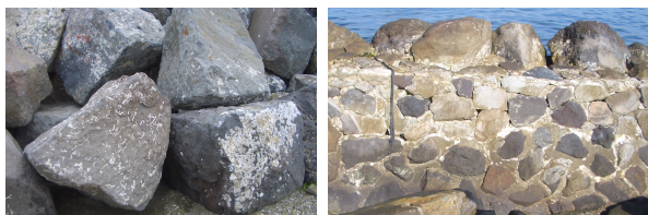
図2 護岸間知石：左：ピンク色, 灰色, 黒灰色の石材, 右：護岸背面の粗石コンクリート
