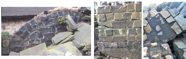
図 8 擁壁前面の露出 左より 東:アーチ擁壁(本体は変形フランス積み)、西:鋼櫓下(イギリス積み優勢)、西:倒壊部裏側(変形フランス積み・モルタル被覆)
