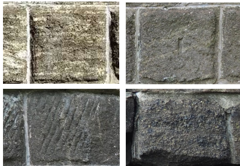
図11 東京湾要塞群の石材と房州石の品種 左上より、井桁目：走水低砲台(第二砲座)、砂目：走水低砲台(第二砲座)、梨目：走水低砲台(第三砲座)、ガリ目：第二海堡
