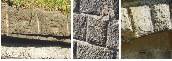
図 17 千代ヶ崎砲台の刻印石 左より、柵門背後の擁壁笠石：ニ、塁道擁壁：I, ㄐ、第一砲座の胸櫓弾室アーチ：I
