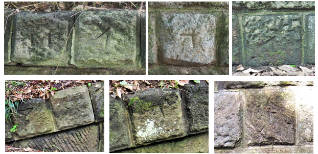
図 15 三軒家砲台の刻印石 軍道擁壁笠石：左上より II, イ, ナ, 第一砲台 ヌ, 第四砲座横櫓笠石：▼, I, 速射砲胸櫓 ト
