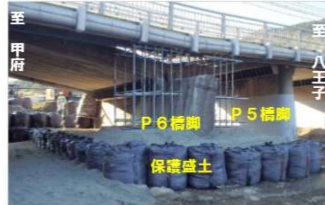
③ 応急復旧 (沈下したP6橋脚の保護盛土)
