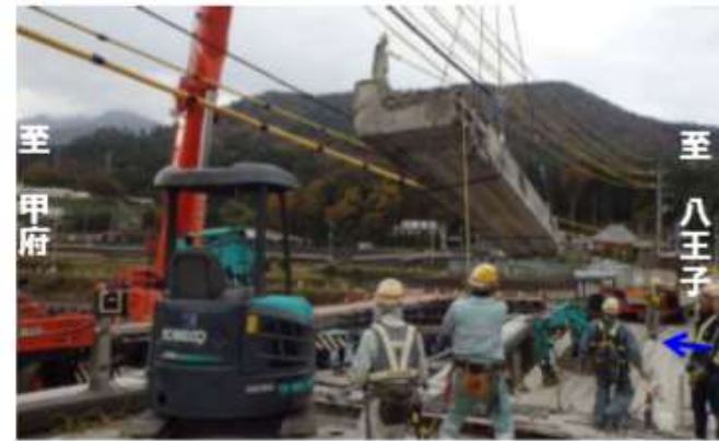
④ 応急復旧中 (P5~A2の橋梁上部工を順次撤去)
