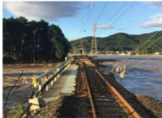
③両毛線 大平下～栃木間 永野川橋りょう 橋台背面流出
