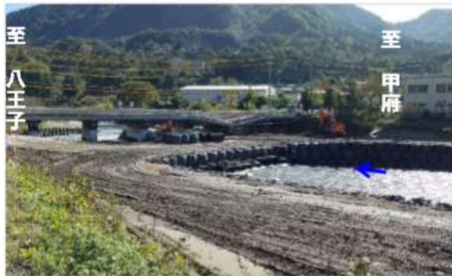
② 応急復旧中 (河川瀬替による工事用ヤード確保)
