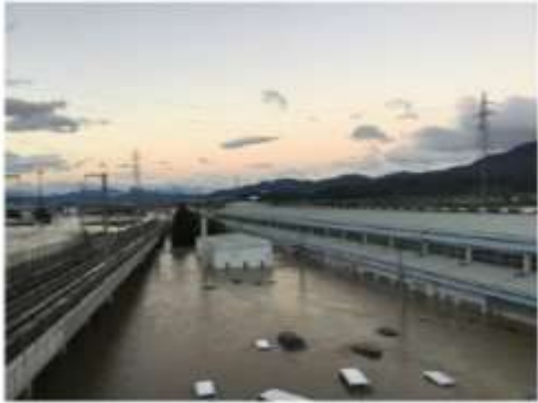
①北陸新幹線 長野新幹線車両センター浸水
