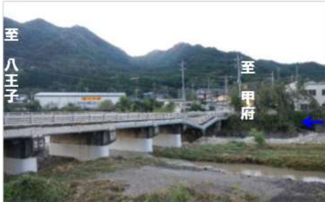
① 応急復旧前 (被災時)
