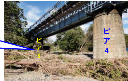
被災後の橋梁下部付近の状況 画像③ (画像の奥にピア6がある)
