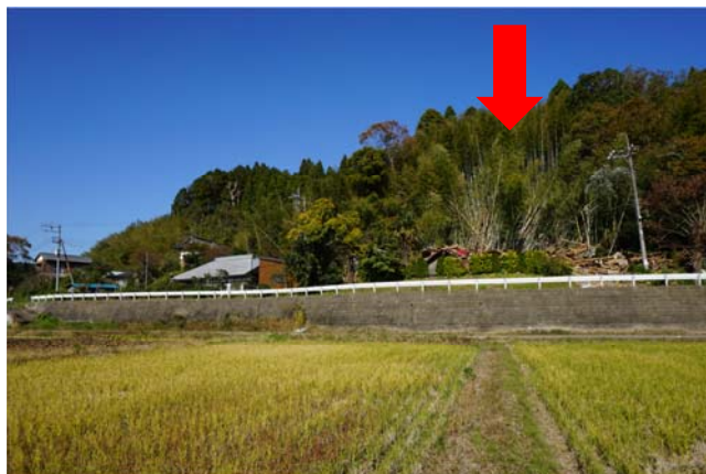
竹藪の表層崩壊 で家屋倒壊
