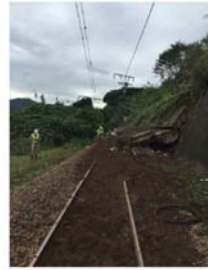
高尾～相模湖間(上り線) 土砂流入およびコンクリート壁崩落 ※神奈川県相模原市緑区付近
