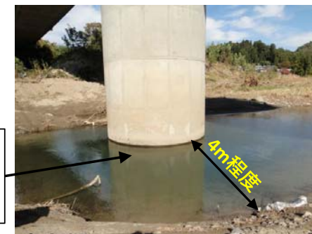
宮平橋橋梁下部付近の状況画像③ ・ピア近傍は水面より2m以上?の洗堀
