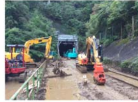
四方津～梁川間(下り線) 土砂流入 ※山梨県大月市梁川町橋之上付近
