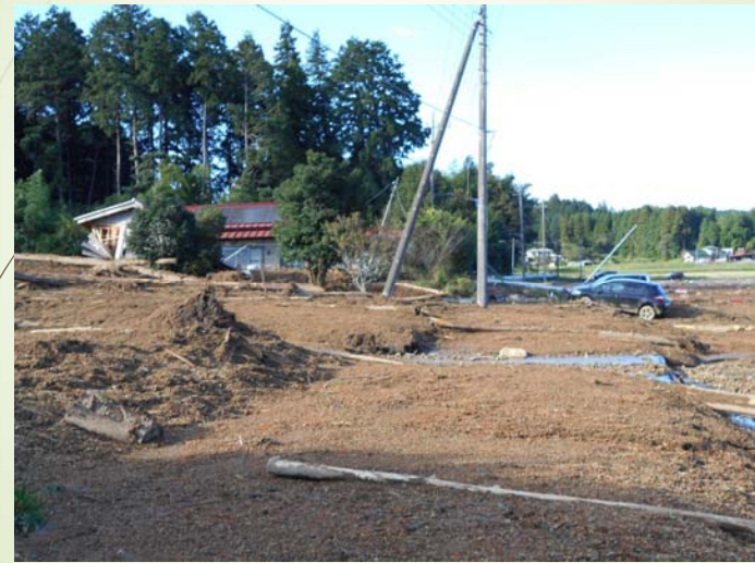
宇都宮市 下小池町 (土石流 下小池二号沢)
