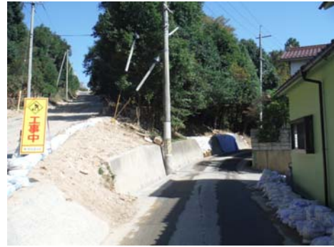
復旧状況（平成 26 年 10 月 10 日）
