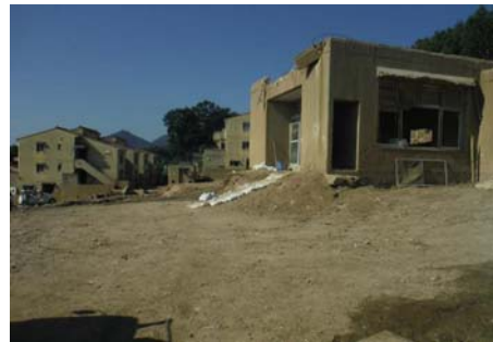
復旧状況（平成 26 年 10 月 10 日）
