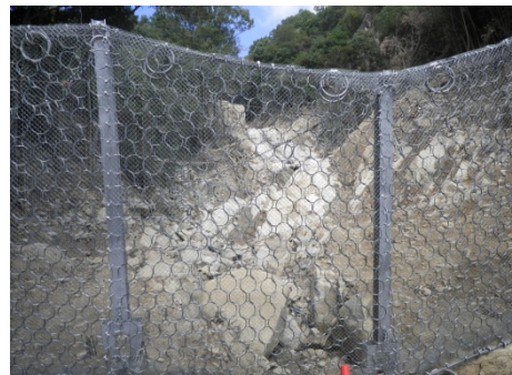
溪流出口に設置された強靱ワイヤーネット（上流の溪床には堅硬な花崗岩が露出する）
