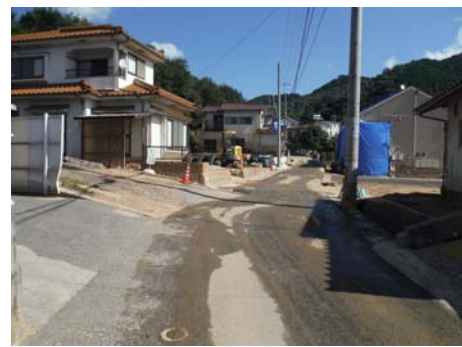
復旧状況 (平成 26 年 10 月 10 日)
