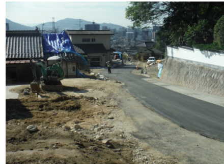
復旧状況 (平成 26 年 10 月 10 日)
