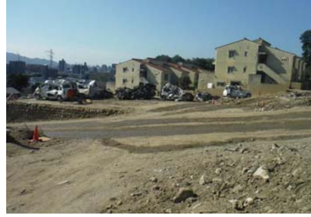
復旧状況（平成 26 年 10 月 10 日）
