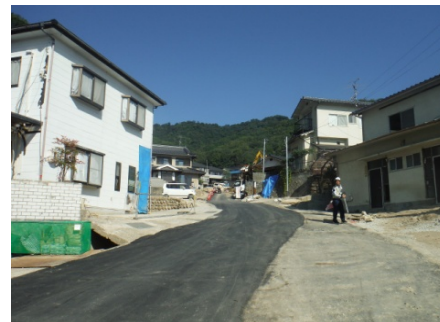
復旧状況 (平成 26 年 10 月 10 日)
