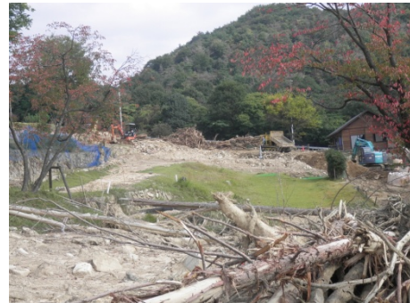
土石流(流木, 倒木を含む)撤去状況
