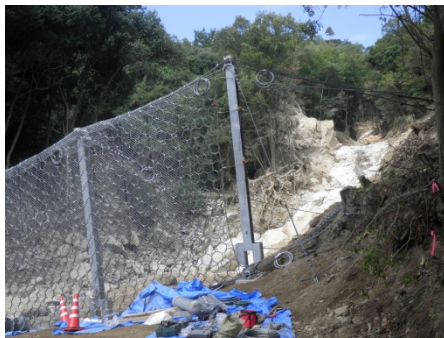
溪流出口に設置された強靱ワイヤーネット（上流の溪床には堅硬な花崗岩が露出する）
