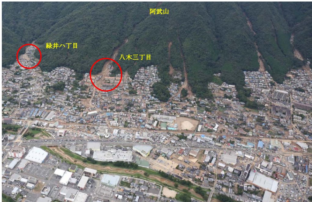
安佐南区八木付近の被災状況：広島市提供資料を加工
