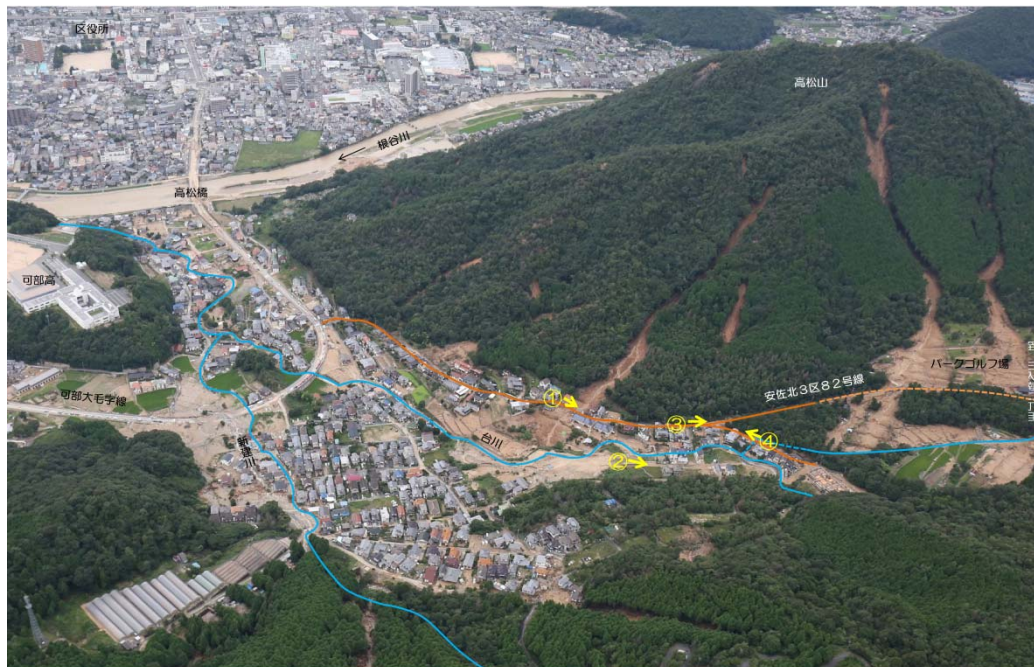
安佐北区可部東六丁目付近の被災状況
