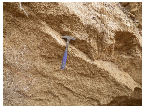
土石流発生溪流左岸の露頭 (全体にマサ化(細粒)している)
