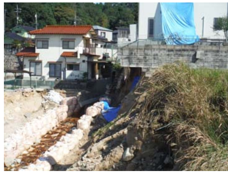
復旧状況（平成 26 年 10 月 10 日）
