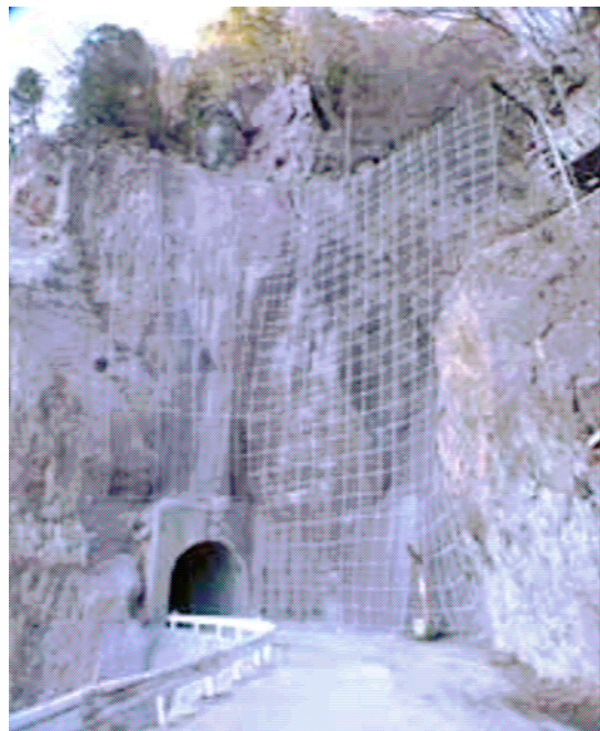
（写真 1）鷹ノ巣での坑口崩壊（左）および 剛繊維モルタル吹付工および落石防護柵（右） （山梨県森林環境部提供）
