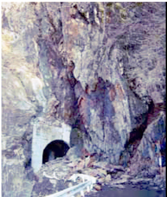
（写真 1）鷹ノ巣での坑口崩壊（左）および 剛繊維モルタル吹付工および落石防護柵（右） （山梨県森林環境部提供）
