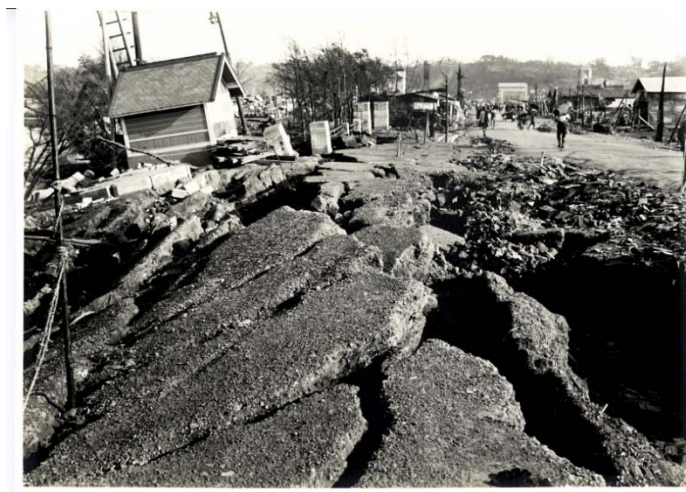
写真 2-関東地震被災横浜
