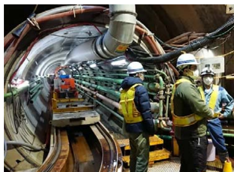
写真-2 大芦川取水放流工導水トンネル坑口
