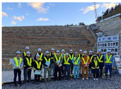
写真-1 ダム堤体建設現場前の集合写真
