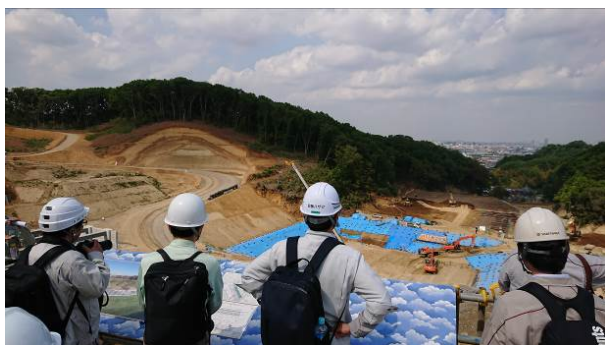
写真-1 高盛土造成現場を歩く
