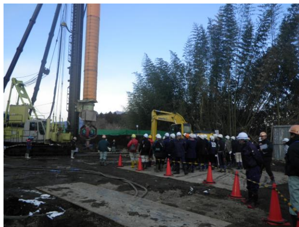
写真-2 現地での地盤改良機見学状況
