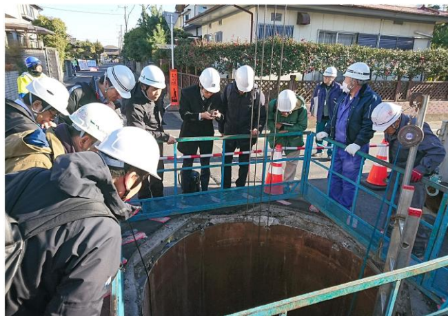
写真-1 現地での立坑の見学状況
