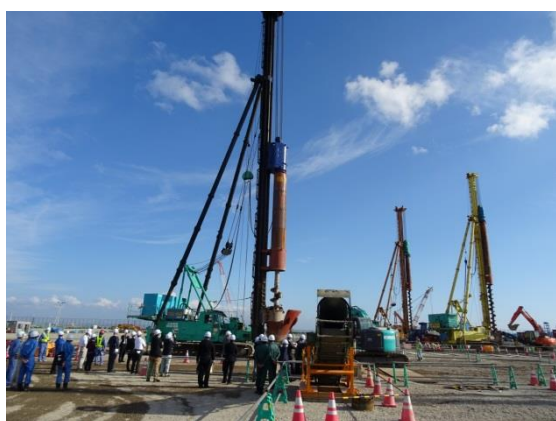
写真-1 現場見学の様子
