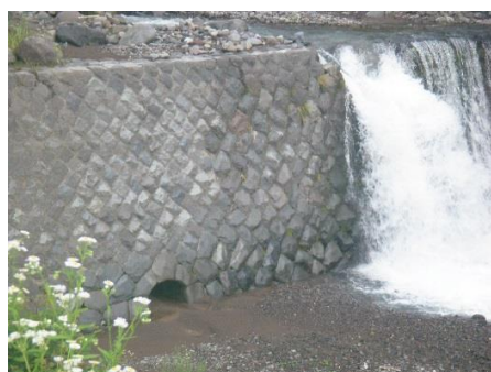
写真-3 稲荷川砂防堰堤群
