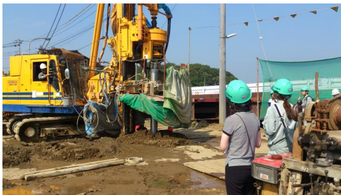
写真-1 実際に施工されている地盤改良杭の見学風景
