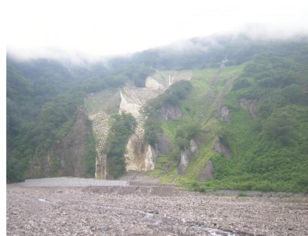
写真-2 稲荷川上流の山腹工現場
