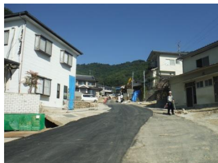
復旧状況 (平成 26 年 10 月 10 日)
