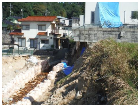
復旧状況 (平成 26 年 10 月 10 日)
