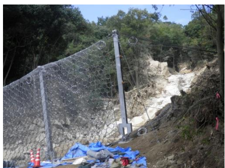
溪流出口に設置された強靱ワイヤーネット
