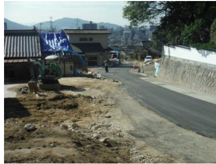
復旧状況 (平成 26 年 10 月 10 日)
