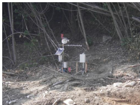
土石流センサーの設置状況
