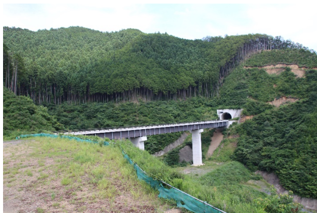
写真-4 付替え県道のトンネルと高架橋
