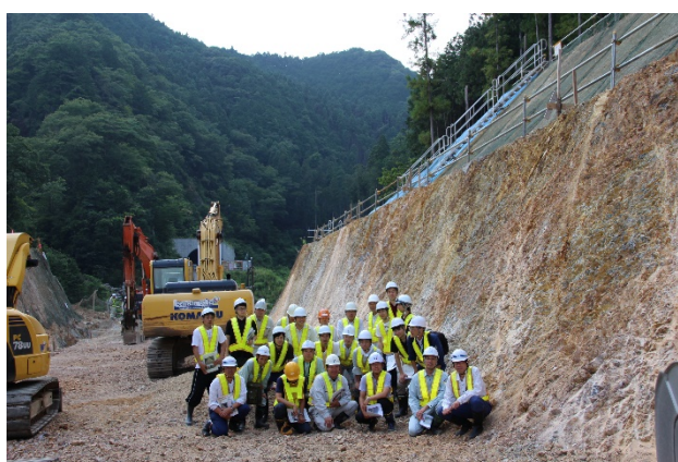
写真-6 付替え県道栗沢7区工事の現場における現場見学会参加者集合写真
