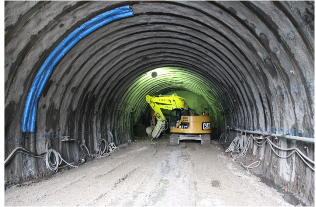
写真-8 トンネル切羽
