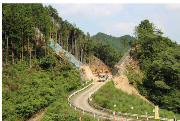
写真-5 付替え県道栗沢7区工事の切土の現場
