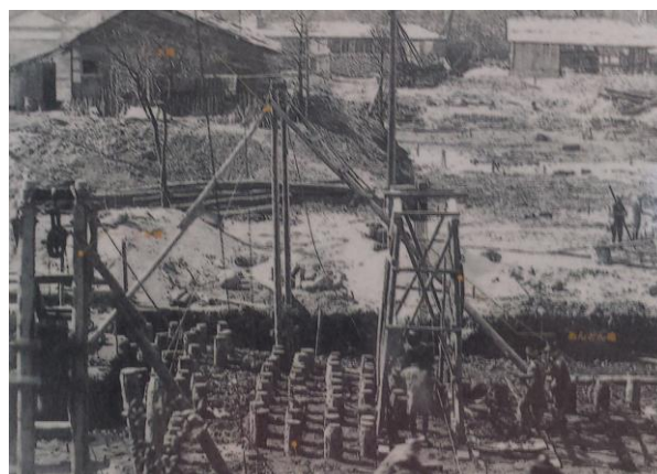
あんどん櫓による松杭の打設の様子
