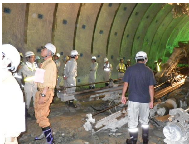
写真-2 トンネル坑内の様子 ジャンプ付近
