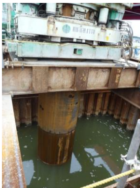
写真-5 大口径ケーシングの打込み
