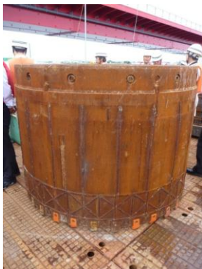
写真-4 大口径ケーシング先端部
