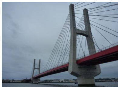
写真-1 架け替えられた銚子大橋
