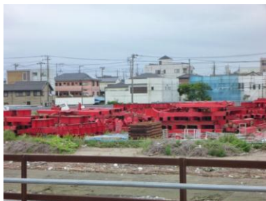
写真-2 撤去された旧橋のトラス部材
