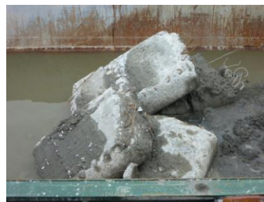
写真-8 引き上げられた橋脚下部のコンクリート片
