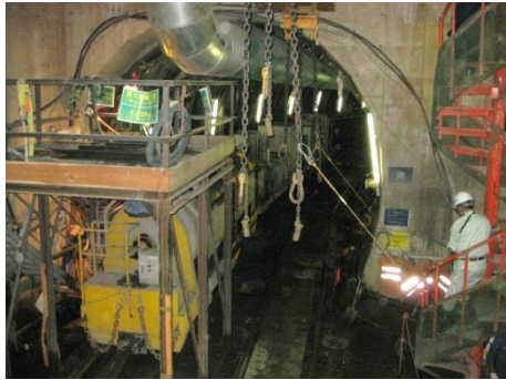
写真-3 立坑直下のトンネル坑口
