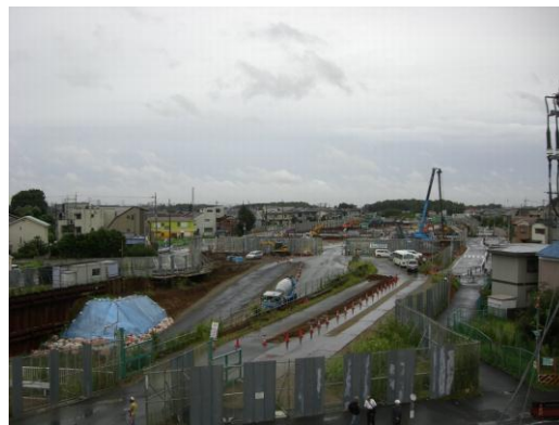
写真4 外環松戸相談所屋上より
