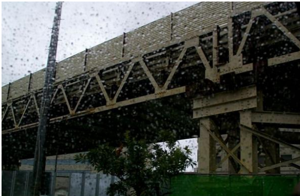
写真1 京葉 JCT 工事地区 (仮設工事用道路)
