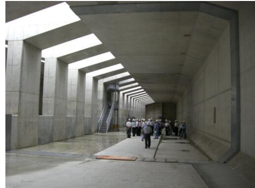
写真2 国分掘割工事地区
