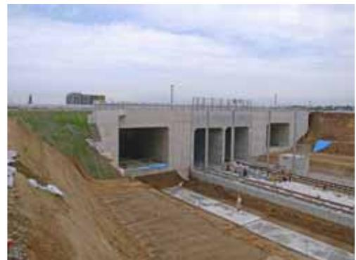
写真-1 : 鉄道用2連ボックスと道路用のボックス
