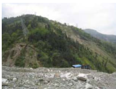
写真-23 土石流で埋まった谷の向こうの斜面の2連の傾斜した送電鉄塔。
