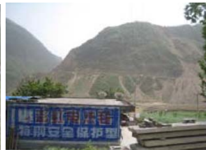
写真-5 李家村-北川間の通口河合流点付近の道路沿い硬岩斜面の崩壊
