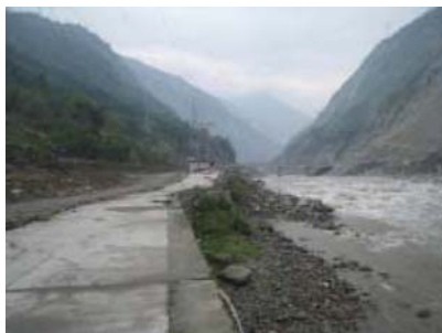
写真-13 映秀-北川断層が民江をほぼ直角に横切る地点：縦ズレ3mほどが残された河床礫の高まりからもよみとれる。横ズレが大きく見れるが、元々の護岸のカーブと思われた。
