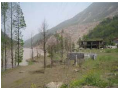
写真-4 李家村-北川間の風化の進んだ斜面崩壊
