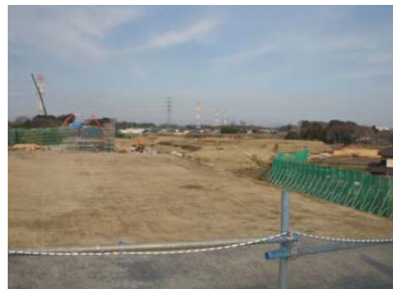
写真-4 桶川JCT土工現場を眺める
