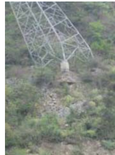
写真-24 手前の送電鉄塔の基礎。下流側基礎は健全に見える。
