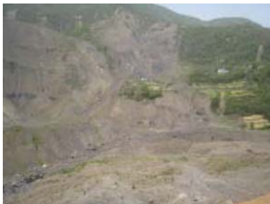
写真-2 風化の進んだ斜面崩壊と巨岩を含まない崩壊砂礫
