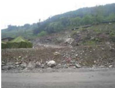
写真-14 民江右岸での断層の走向（傾斜した電柱の位置を通過）
