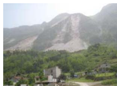
写真-6 李家村-北川間の新鮮な硬岩斜面の巨礫を含む崩壊
