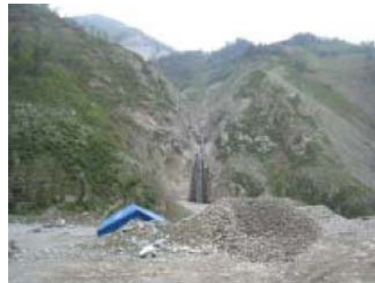
写真-18 数十メートル高さで3段ほどの滝を飛び越え直接下の谷を埋めて、滝は50mほど短くなった。周囲の斜面に飛散礫が見られる。
