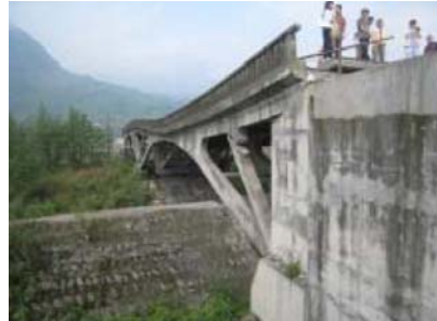
写真-27 小魚洞大橋の落橋を左岸部から見る。
