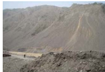
写真-3 李家村-北川間の風化の進んだ斜面崩壊
