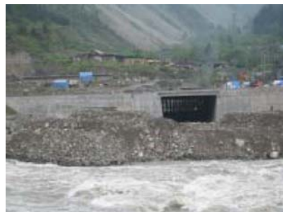
写真-15 民江左岸での断層の走向（手前の護岸は修復済みと思われるがその先の橋桁や家屋が傾斜している）
