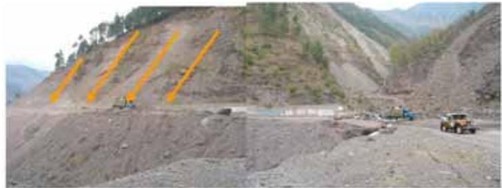
図11 斜面の切土工事によって設けられた地方幹線道路(バラコット北方にて)
