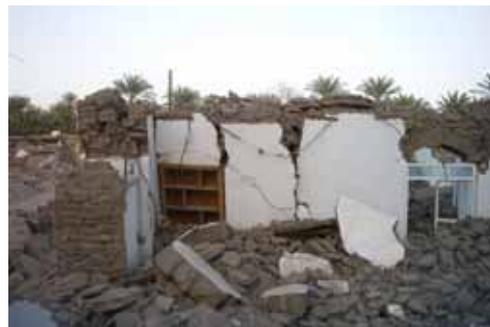
図2 バム地震におけるアドベ家屋の崩壊例
