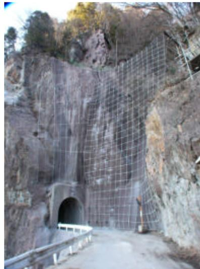
(写真1) 鷹ノ巣での坑口崩壊(左)および 剛繊維モルタル吹付工および落石防護柵(右)
