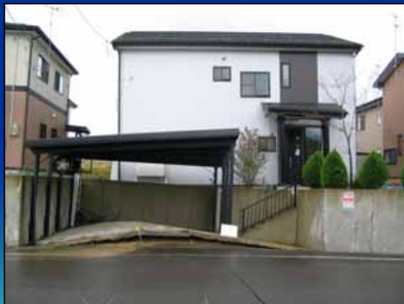
【地盤の液状化】
